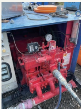
ポンプで浄化液を圧送
