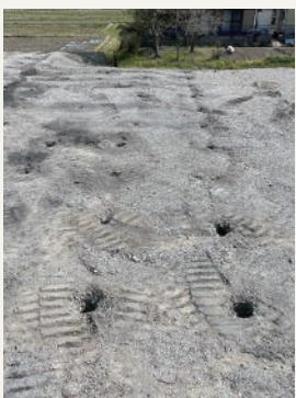
削岩機で穴を掘る
