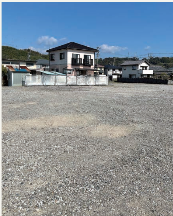
土壌浄化工事完了
