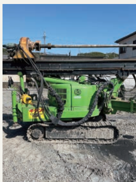
固い土壌のため削岩機を使用
