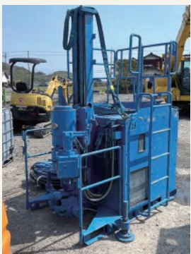
注入機で浄化液を注入
