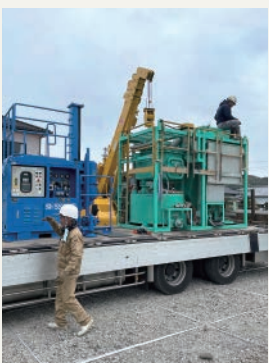
混合プラントの搬入
