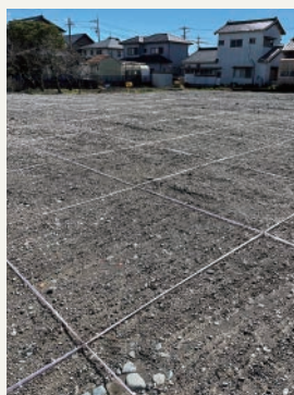
汚染箇所に係張り
